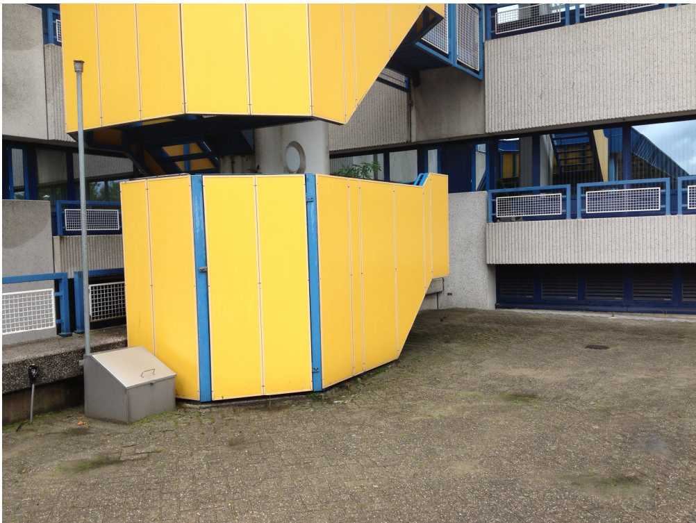
Foto 6, locatie tank buiten de onderzoekslocatie.
