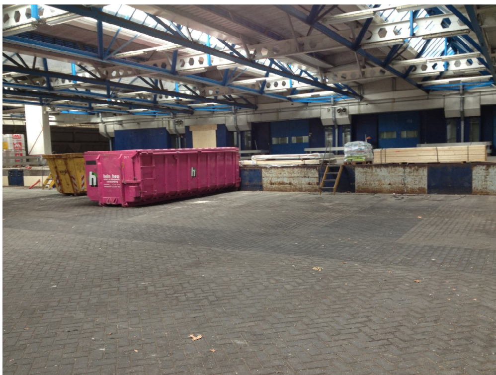
Foto 2, overzicht locatie onder de overkapping
